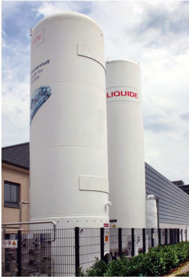
☛ The laboratories are being supplied with hydrogen (50,000 l) and nitrogen (nearly 32,600 l) from big tanks. Die Labore werden aus großen Tanks mit Wasserstoff (50.000 l) und Stickstoff (knapp 32.600 l) versorgt.
